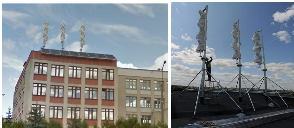
Rysunek 20. Wiatraki z pionową osią obrotu na budynku szkolnym w warunkach miejskich
